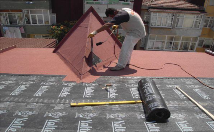
Şəkil 7.2. Dam örtmə işi.
