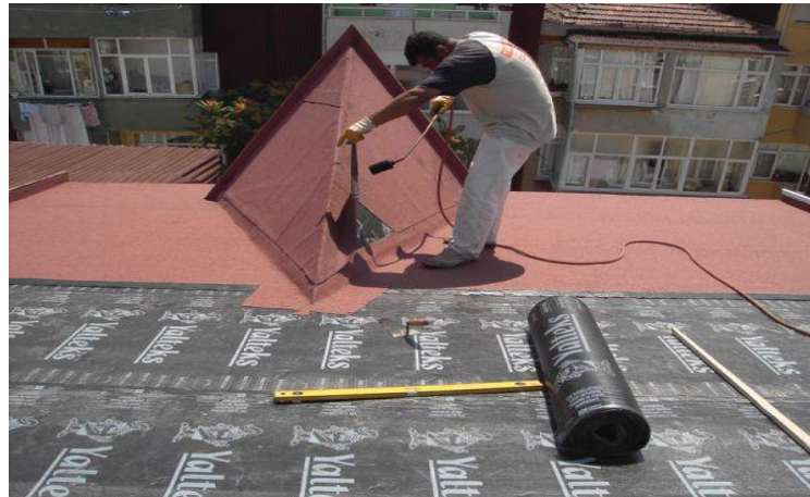
Şəkil 7.2. Dam örtmə işi.
